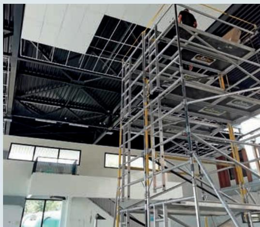
L'intervention sur les plaques de faux-plafond a nécessité la mise en place d'un échafaudage au sein de la piscine.
